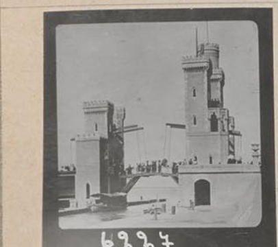
Brücke des Haudamms Hairo.
