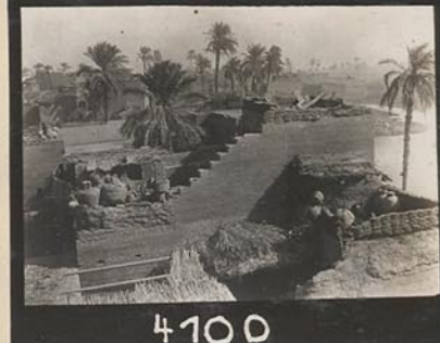
Wohnhaus mit offener Treppe zum Obergeschoss.
